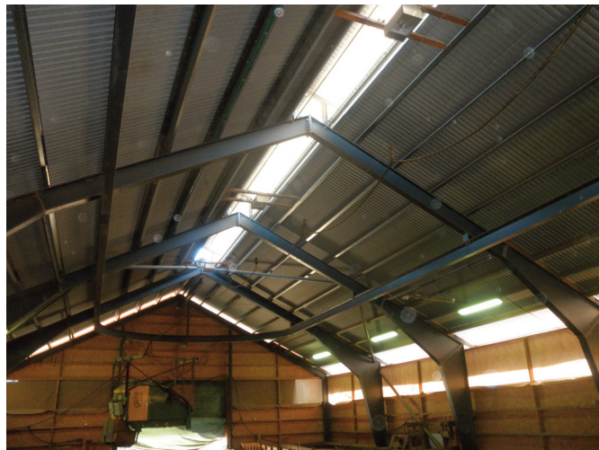
Uisolert fjøs med og vindbremseduk som luftinntak og opphøya møne av lysplater som lufuttak.
