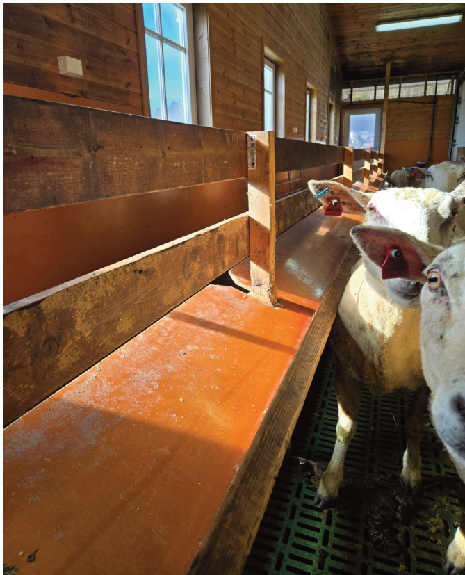
Kombinert drivgang langs vegg og kraftfôrkrybbe.
