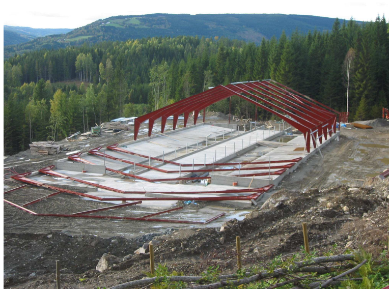
Bygning under oppføring, foto: A. Bergum
